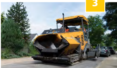
3 Stade, Asphaltarbeiten von innerstädtischen Straßen
