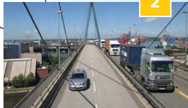
2 Hamburg, öffentliche Beleuchtung und Kabelleitungstiefbau
