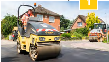
1 Celle, Asphaltarbeiten am Heeresflugplatz
